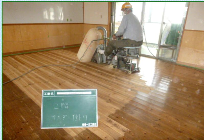
2. 床の汚れ、付着物、旧塗膜を取り除くため表面を削り取ります。
