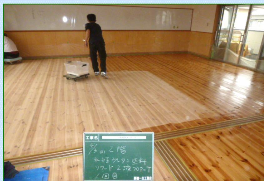
5. 塗料を①下塗りして乾いたら、研磨、清掃②中塗りして乾いたら、研磨、清掃③上塗りと3回塗ります。
